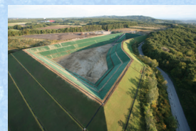
Hayakita Disposal Site
