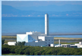
【行政施設】 北石狩衛生センター (一般廃棄物焼却工場の運営受託)
