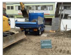
現地工事(掘削・搬出)
