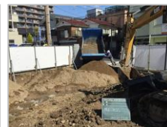
現地工事(埋め戻し)
