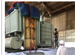
大型トランス作業の様子 上写真：運搬風景 下写真：搬入風景
