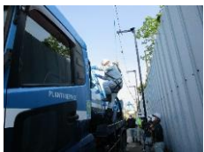
墜落制止器具の特別教育(バキューム車の取扱い)
