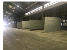
川崎工場 資源循環プラント設備
