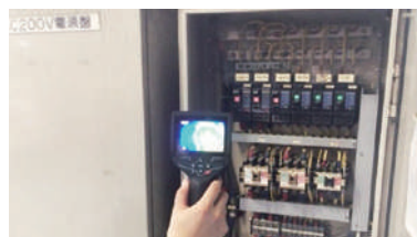
電気設備の点検
